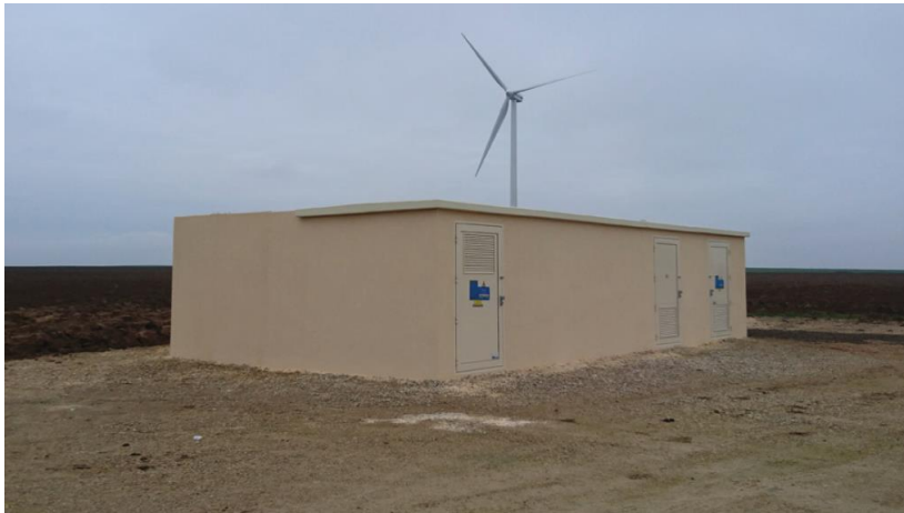
Figure 4 : exemple du poste de livraison double du parc de la Grande Pièce en crépis beige
